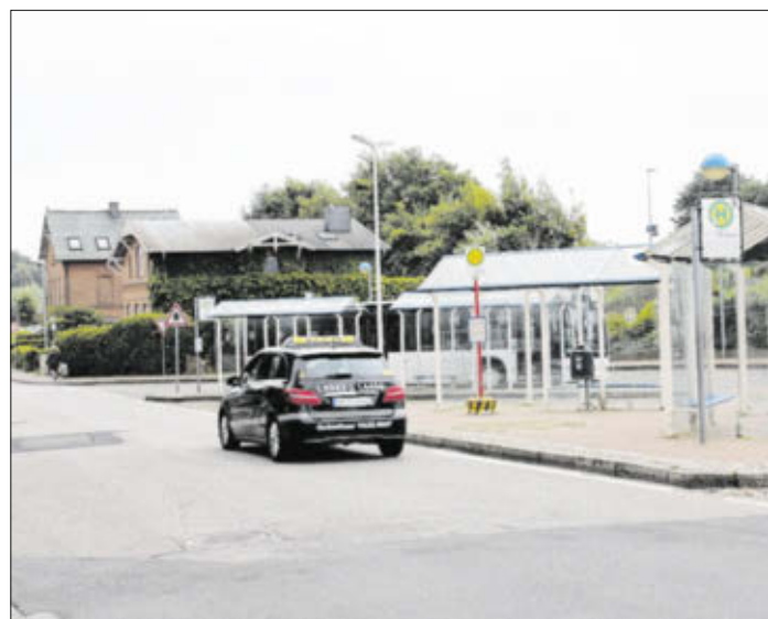
Der Eutiner ZOB vor dem grundlegenden Umbau. Zwei Häuser (hinten) müssen dafür abgerissen werden. Foto: Peyronnet
